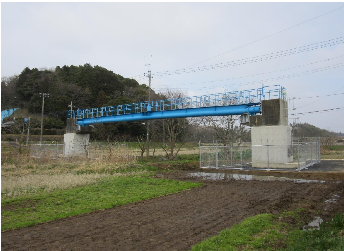
高崎川水管橋
