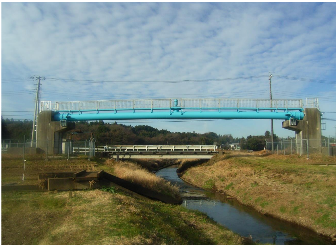
勝田川水管橋
