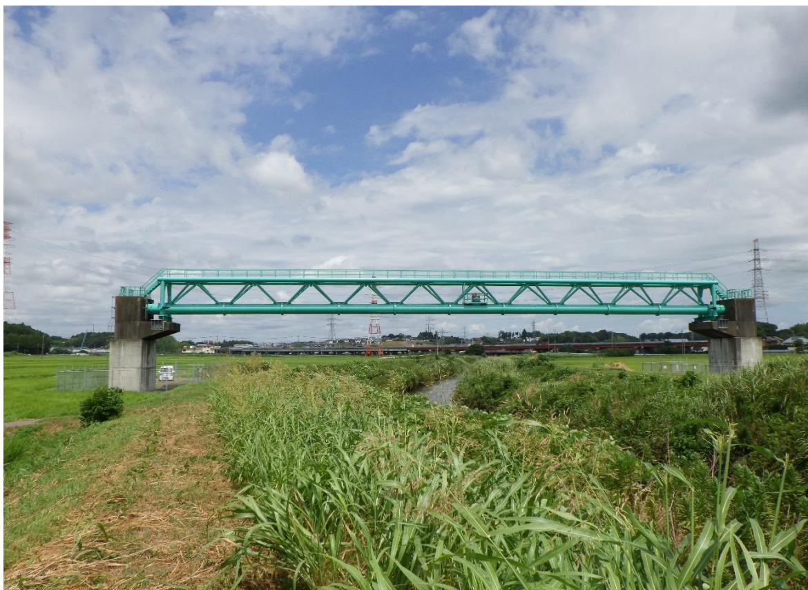
鹿島川水管橋
