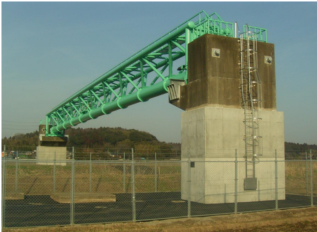
落橋防止装置及び耐震補強コンクリートを施した鹿島川水管橋(平成 25 年 3 月完成)
