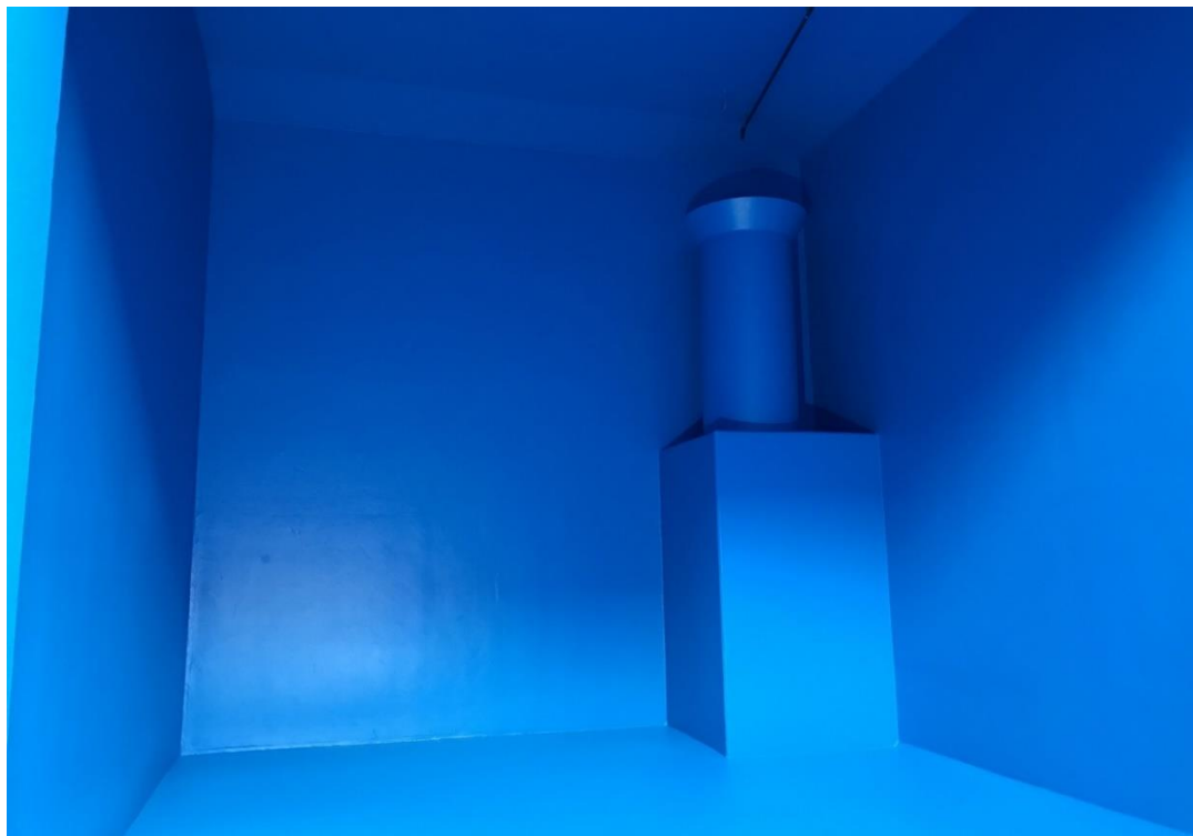
耐震補強を施した印東加圧ポンプ場 1・2号調整池内面② (令和 5年 3月完成)
