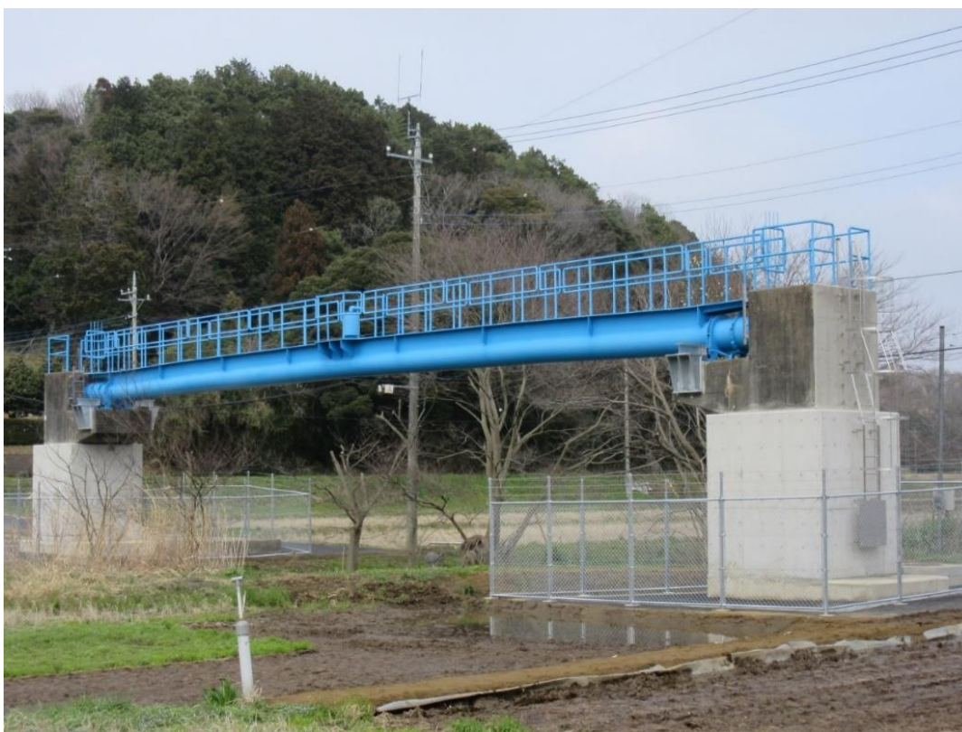
落橋防止装置及び耐震補強コンクリートを施した高崎川水管橋(平成 27 年 3 月完成)
