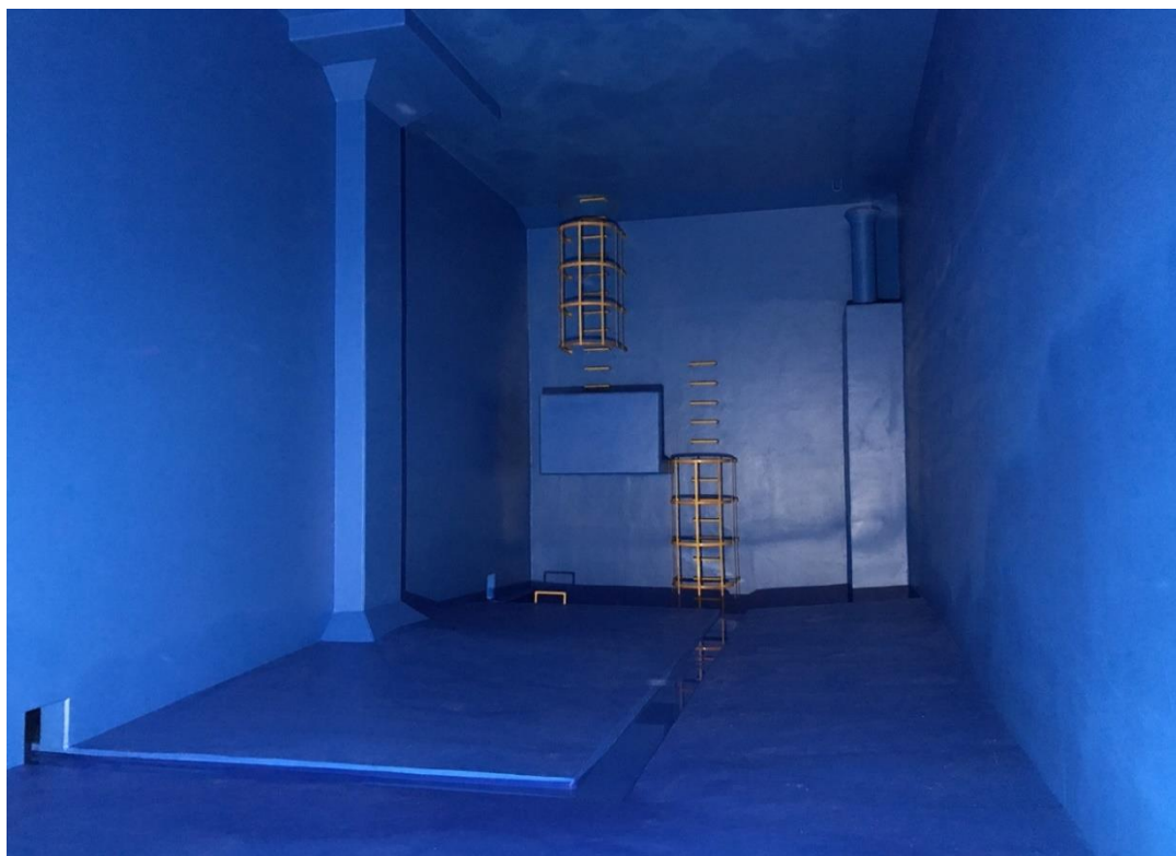
耐震補強を施した印東加圧ポンプ場 1・2号調整池内面③ (令和 5年 3月完成)
