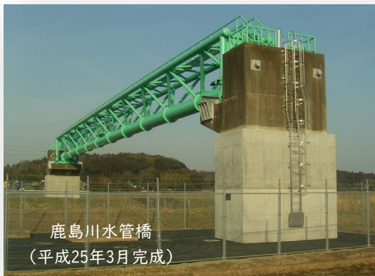
落橋防止装置および耐震補強コンクリートを施した水管橋
