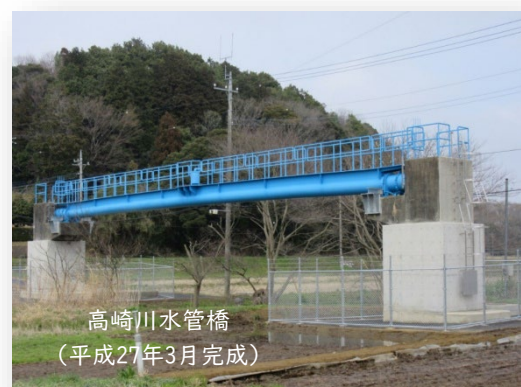
落橋防止装置および耐震補強コンクリートを施した水管橋
