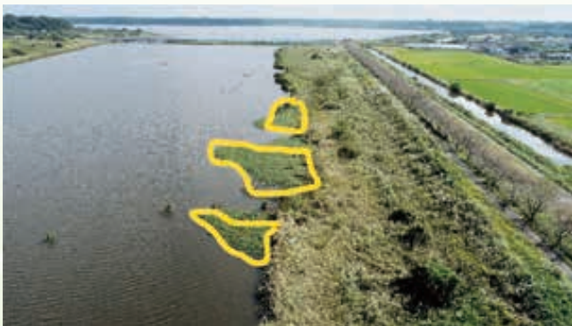
R4. 10. 16 (舟戸大橋右岸)
