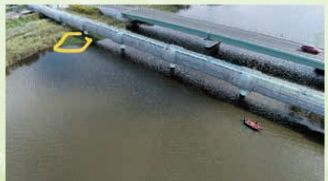
R4. 10. 16 (舟戸大橋左岸)
