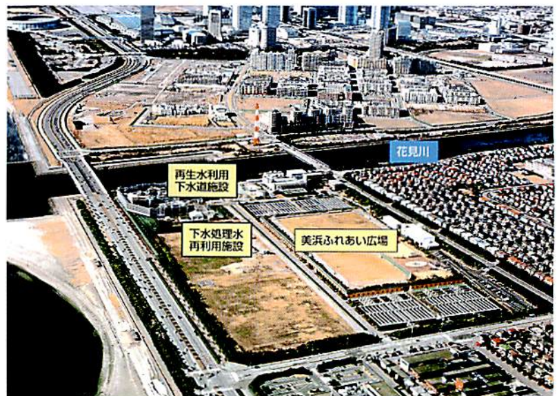
花見川終末処理場を上空からみた写真
