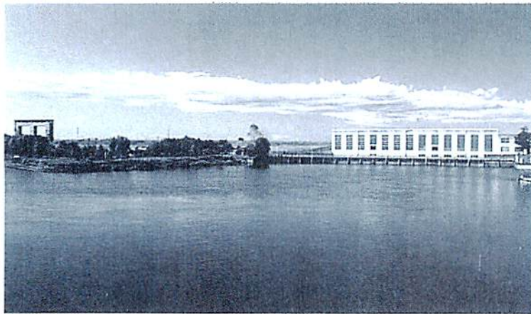
印旛排水機場
