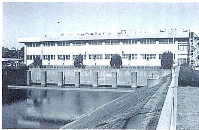
大和田排水機場
